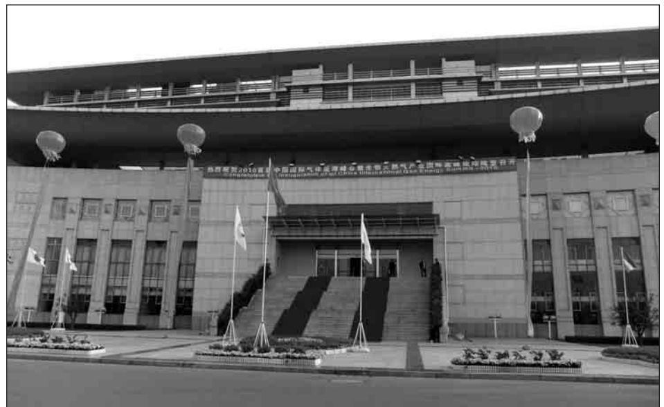
Façade de l'hôtel de ville d'Anyang, province de Henan
