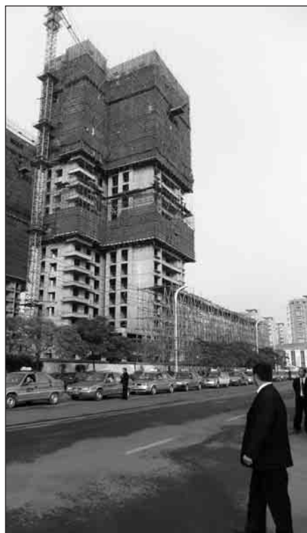
Immeubles en construction à Anyang, Chine
